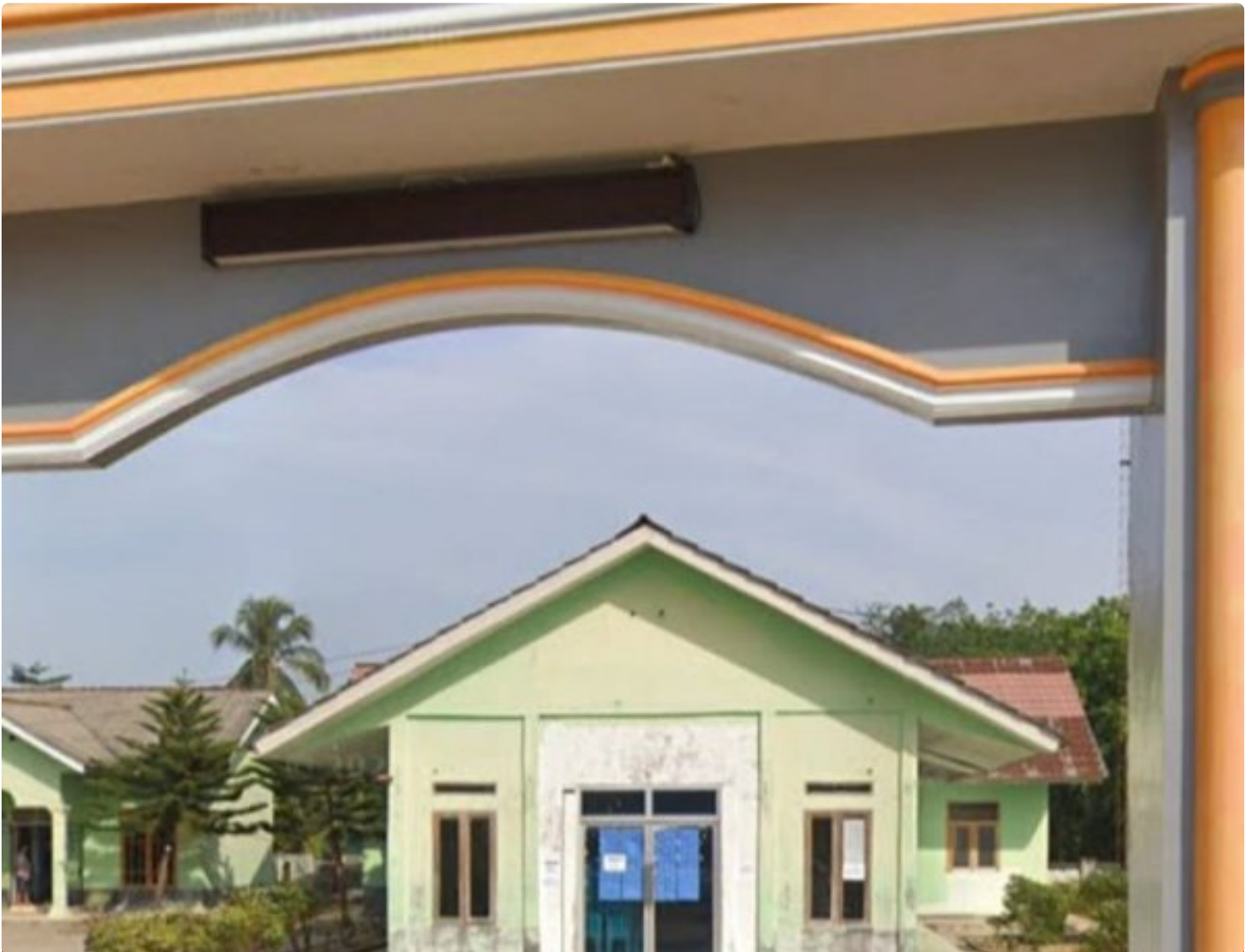
Balai desa Muara Tenang Tanjung Raya
