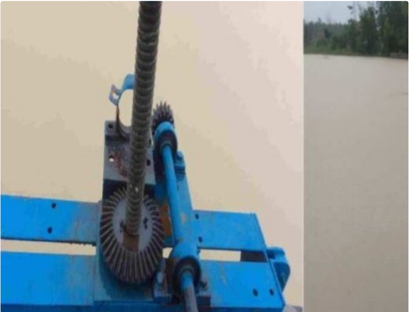
Pintu air Albaret Simpang Mesuji
